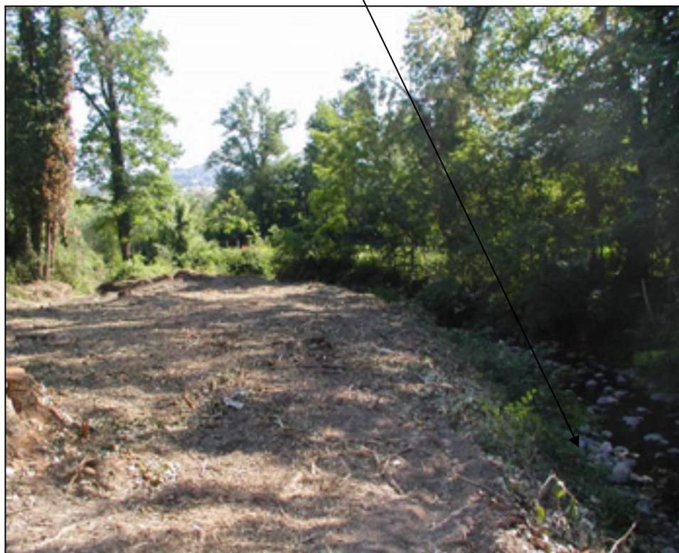
Avant travaux, juin 2004
