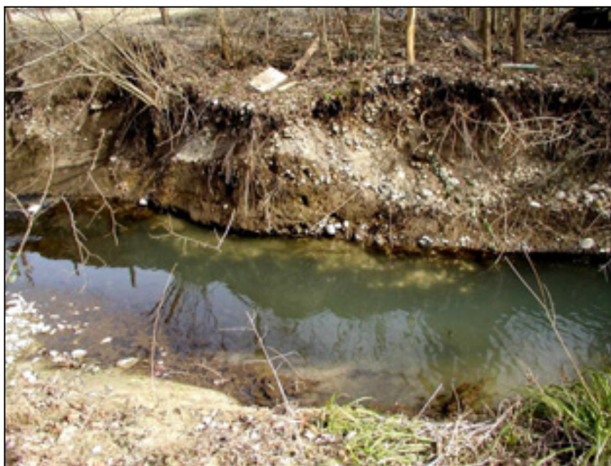
Figure 9 : Le Dadon, berge déstabilisée en rive droite
