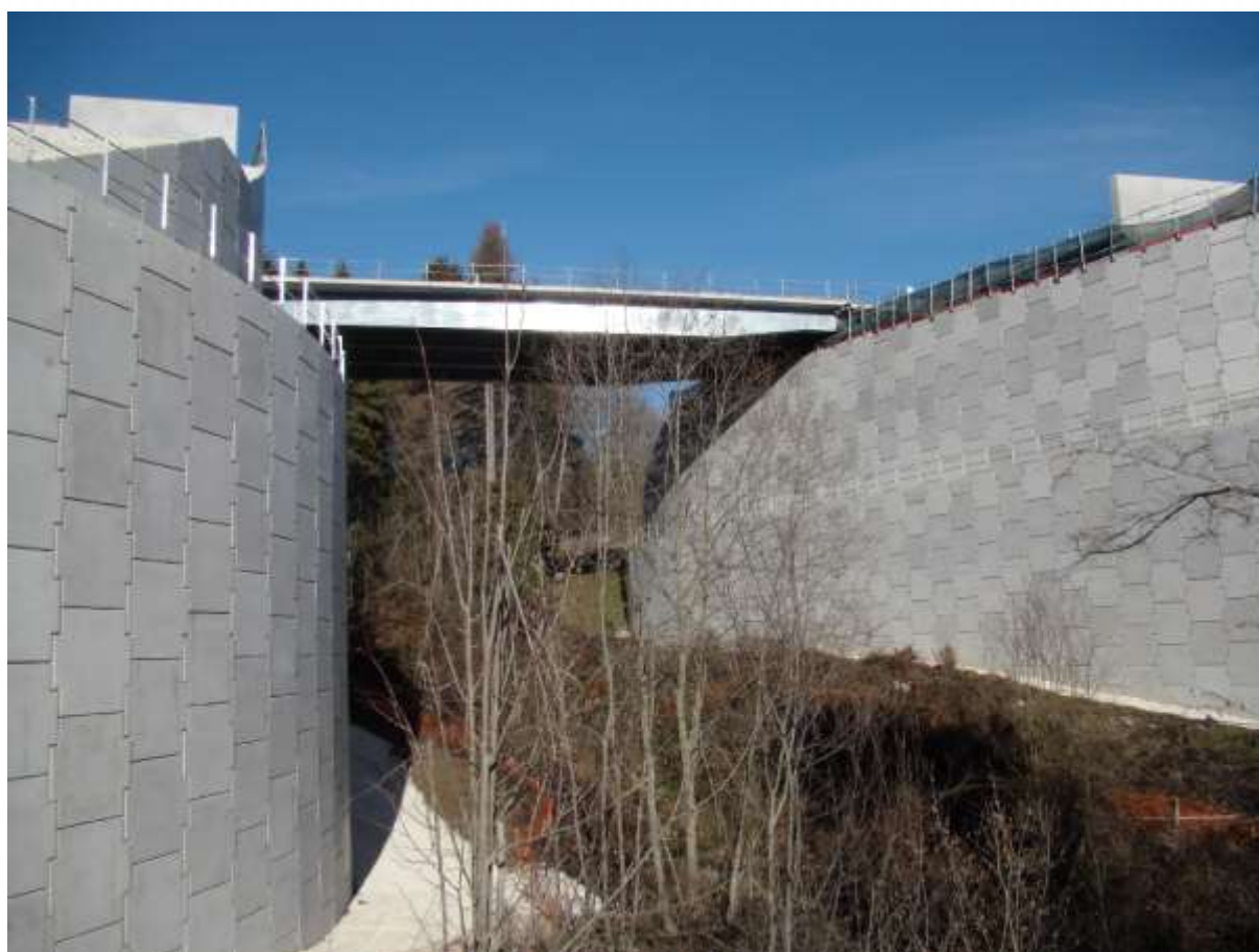
Photo 4 : Pose du tablier sur la Ravoire (janvier 2008)
