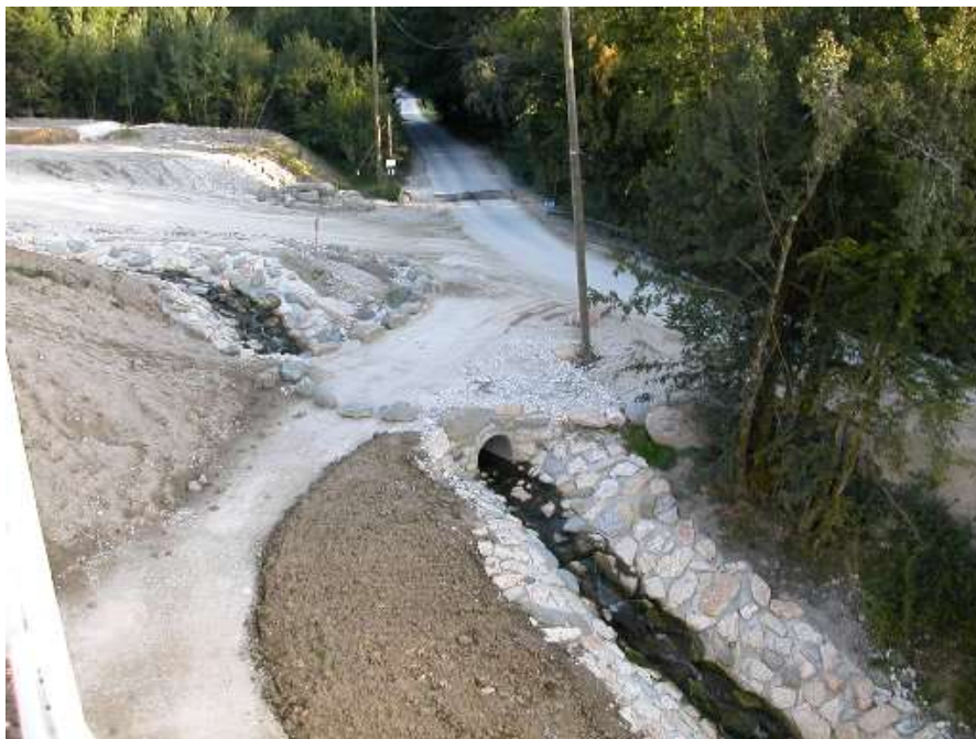
Photo 7 : Aménagement du franchissement du ruisseau de Bougy aval en aval de l'autoroute (juillet 2007)
