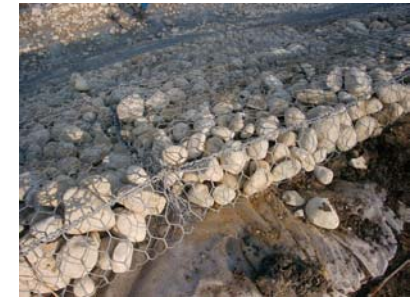
Exemples de mise en œuvre de matelas RENO
