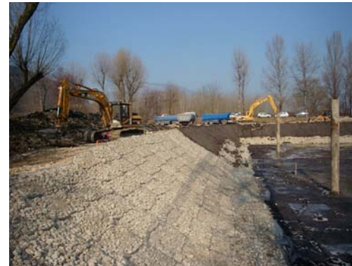
Exemples de mise en œuvre de matelas RENO
