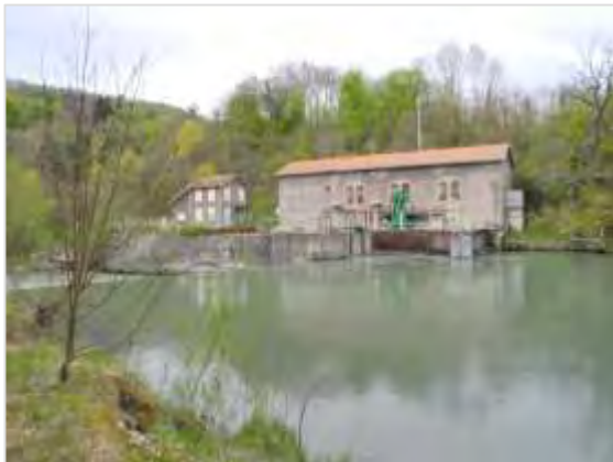
Figure 10 : vue amont du seuil d'Arthaz
