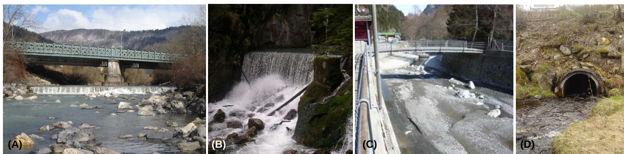
Figure 6 : Exemples d'infrastructures en Haute-Savoie pouvant impacter sur le fonctionnement naturel du cours d'eau et la continuité de la loutre: (A) Seuil du pont SNCF à Marignier sur le Giffre haut de 1,10 m ; (B) Barrage du Thuet sur le Bronze haut de 4 m ; (C) Barrage de la douane franco-suisse ; (D) du parking Buse au niveau du col des Montets sur le ruisseau de Tré le Champ d'une longueur de 60 m et d'un dénivelé de 2,20 m © FDPPMA 74 et Asters.
