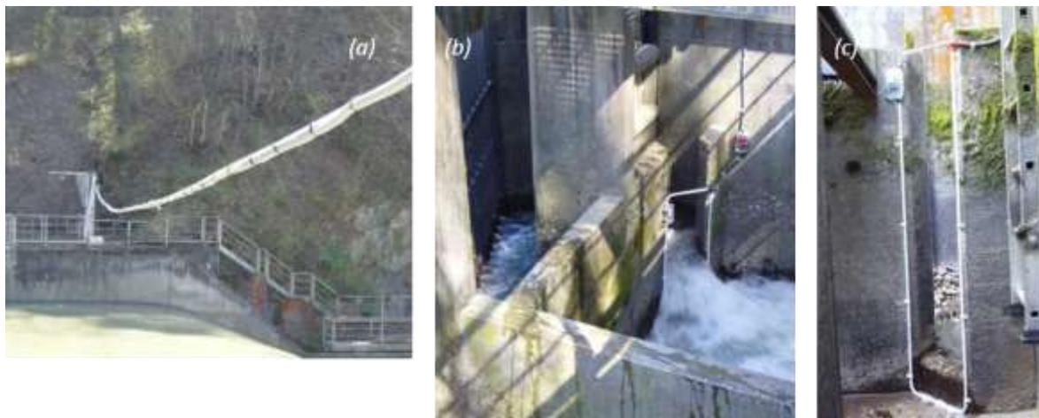
Figure 10 : (a) câble qui traverse l'Arve sur 52 m, (b) et (c) antennes PITtag fixées au niveau des ouvertures des bassins
