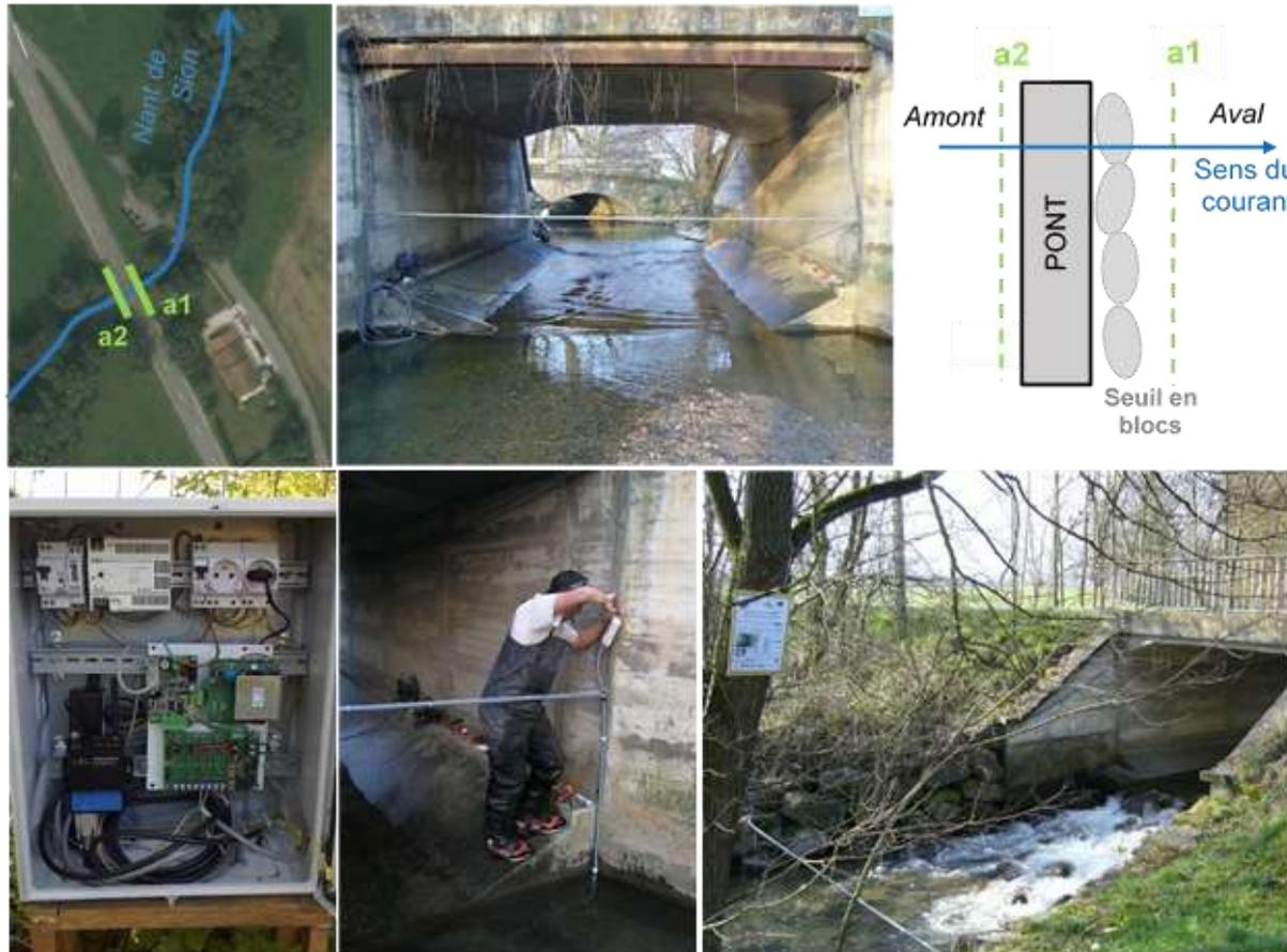
Figure 11 : Mise en place de la station PITtag du Nant de Sion ; (a) vue aérienne du site ; (b) antenne 2 vue depuis l'amont ; (c) schéma explicatif de l'implantation des 2 antennes ; (d) boîtier électrique relié au lecteur Oregon posé chez la propriétaire riveraine ; (e) branchement et réglage de l'antenne 2 ; (f) antenne 1 vue depuis l'aval avec le panneau d'information sur la station en rive gauche
