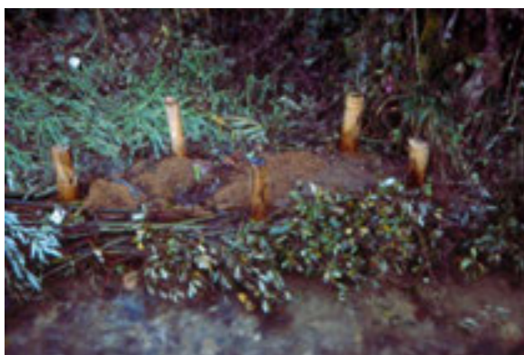
Sous-berge une fois le coco positionné
