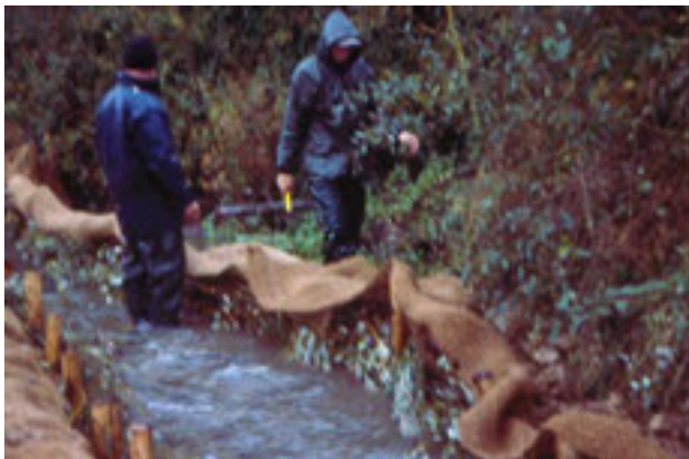
Mise en place du tressage et du coco
