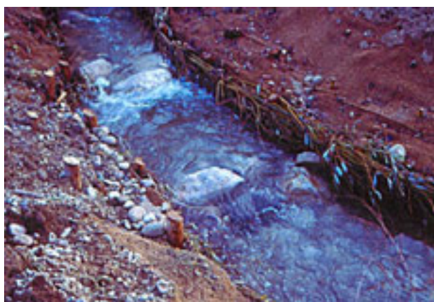
Vue de deux seuils en pierres construits dans le lit
