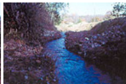
...juste après les travaux
