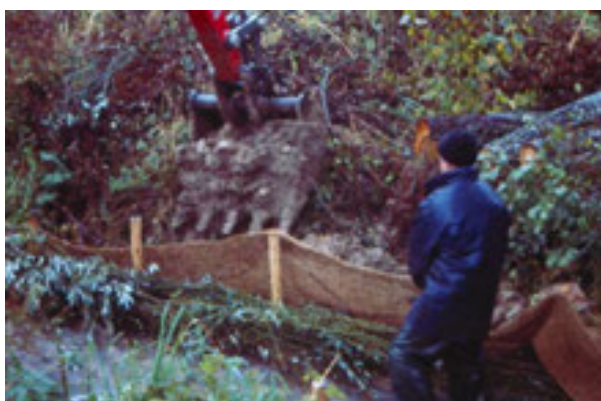
Mise en place de la terre derrière le tressage à l'aide d'une pelle mécanique
