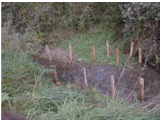
Enfoncement des pieux en châtaignier
