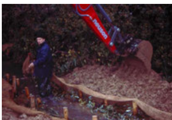
Mise en place de la terre derrière le tressage à l'aide d'une pelle mécanique
