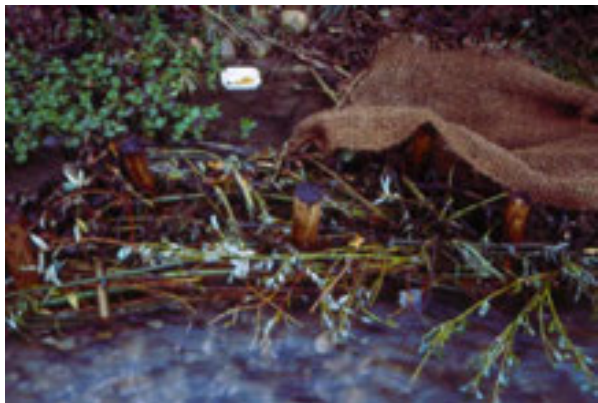
Mise en place d'une double rangée de pieux et d'un double tressage
