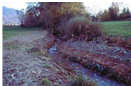
...juste après les travaux
