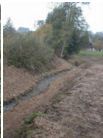
...juste après la réhabilitation
