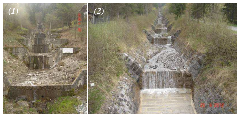
Figure 2 : Travaux de correction des profils en long pour la maîtrise des processus de transit sédimentaire : (1) Nant de la Ripaz, commune de Magland ; (2) Nant de Vernay, commune de Passy (Auteur : J-M Richardot, ONEMA 2010)
