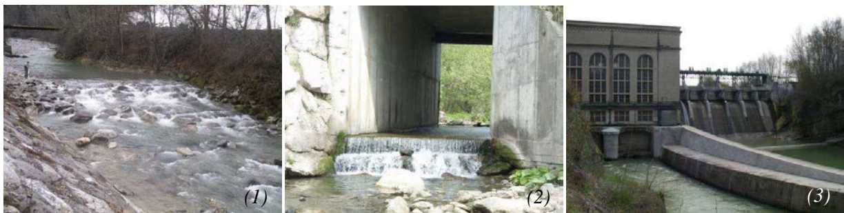
Figure 22 : Illustrations des types d'ouvrages rencontrés dans le département (1) seuil en enrochements libres pour la stabilité du profil en long, (2) ouvrage de franchissement routier ; (3) ouvrage de production hydroélectrique (Auteur : FDPPMA 74)
