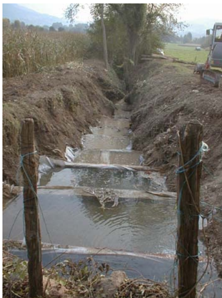
Vue de l'amont
