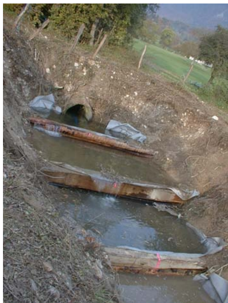
Vue de l'aval.
