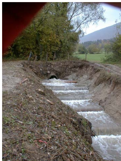
Vue de l'aval.
