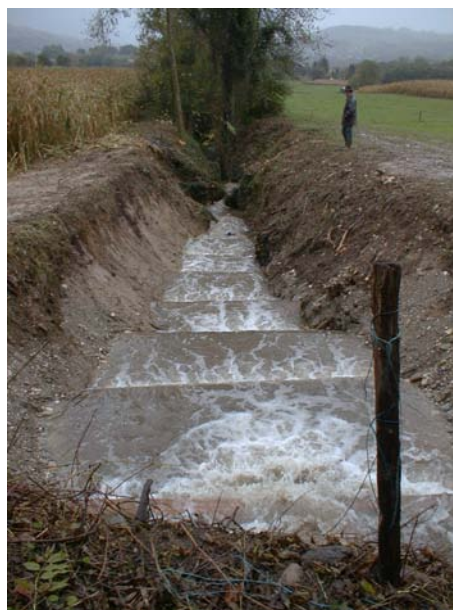
Vue de l'amont
