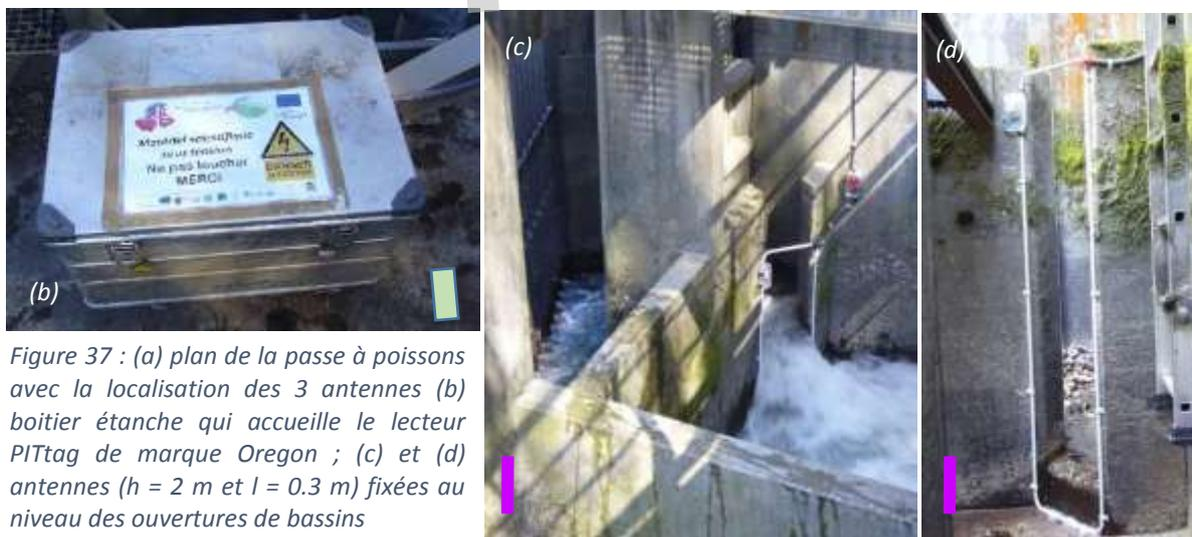
Figure 37 : (a) plan de la passe à poissons avec la localisation des 3 antennes (b) boîtier étanche qui accueille le lecteur PITtag de marque Oregon ; (c) et (d) antennes ( $h = 2\text{ m}$  et  $l = 0.3\text{ m}$ ) fixées au niveau des ouvertures de bassins
