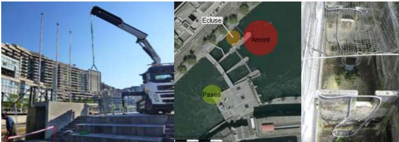
Figure 35 : Mise en place du dispositif PITtag sur le barrage du Seujet – Genève. (a) moyen mis en œuvre pour réaliser la vidange de la passe à poissons ; (b) localisation des différents dispositifs qui équipent le site pour le suivi piscicole ; (c) antennes PITtag dans la passe à poissons
