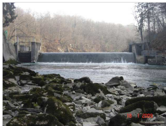
Figure 11 : vue aval du seuil d'Arthaz - source : Chasserieu, C. 2009
