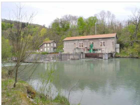
Figure 10 : vue amont du seuil d'Arthaz
