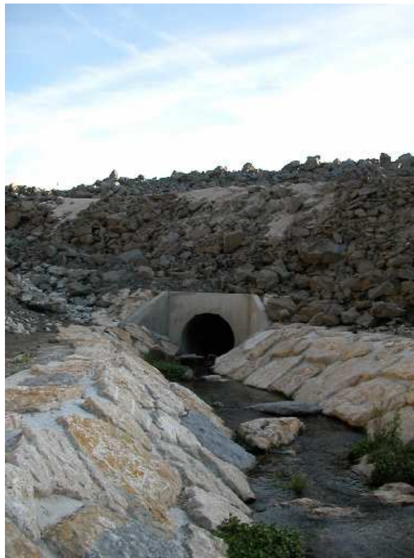
Photo 7 : Aménagement du franchissement du ruisseau de Bougy aval en amont de l'autoroute (juillet 2007)
