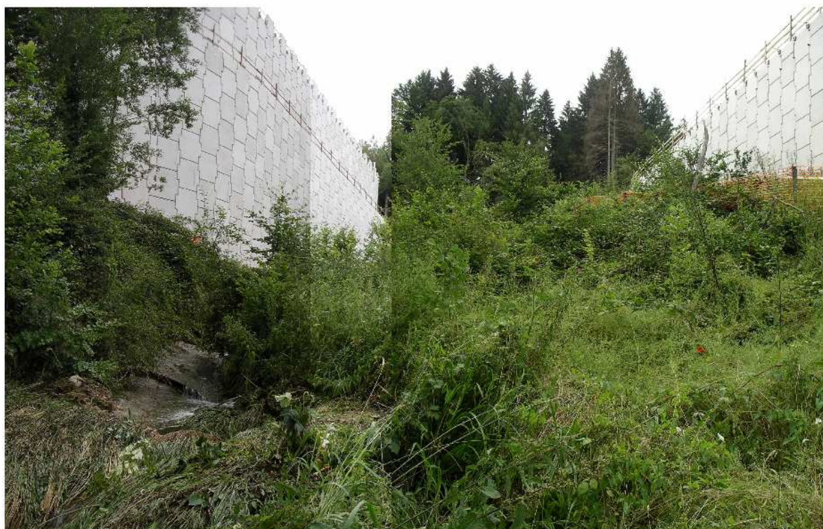
Photo 3 : Vue du chanteir au niveau du franchissement du ruisseau de la ravoire (juillet 2007)
