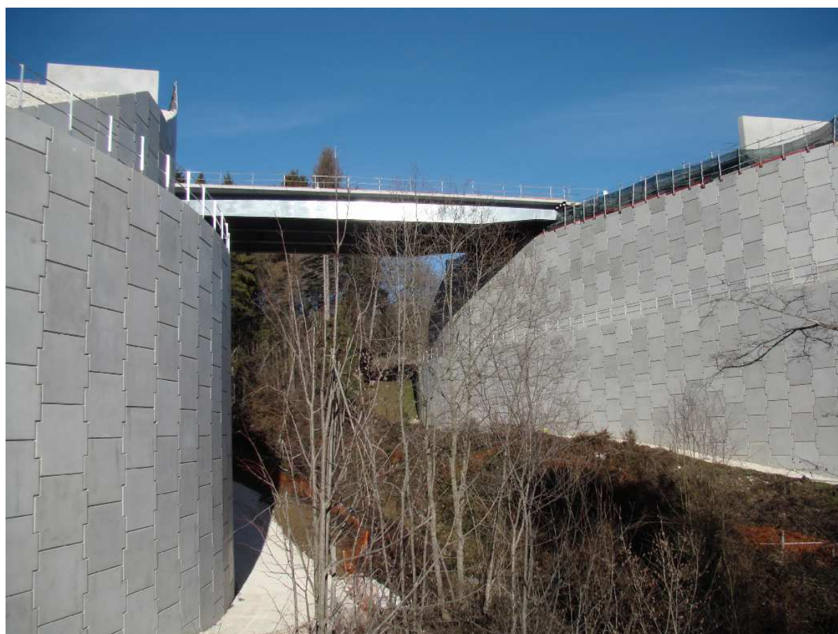
Photo 4 : Pose du tablier sur la Ravoire (janvier 2008)
