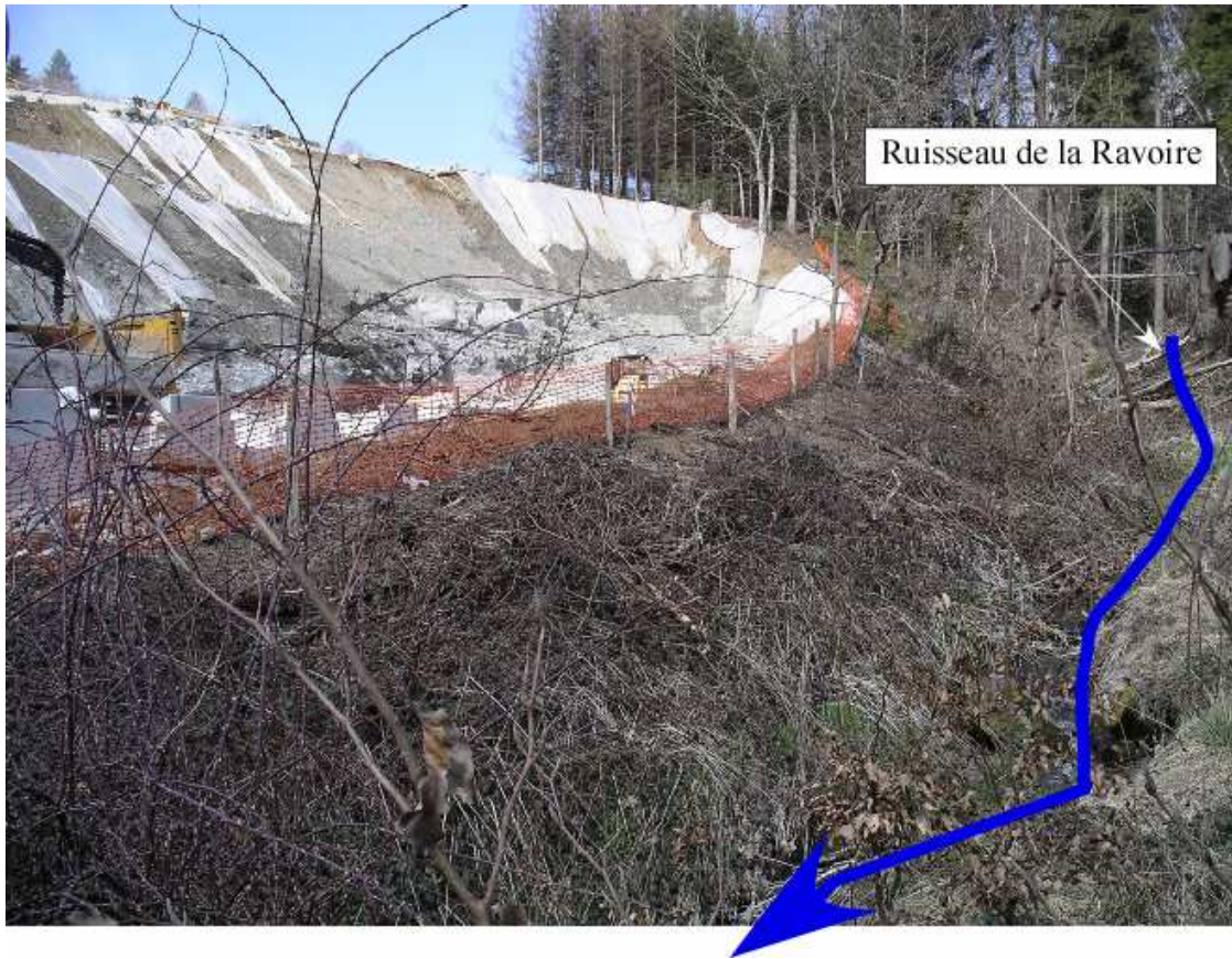
Photo 1 : Mise à nu des sols en bordure de cours d'eau lors de la phase préparatoire des travaux (mars 2007)
