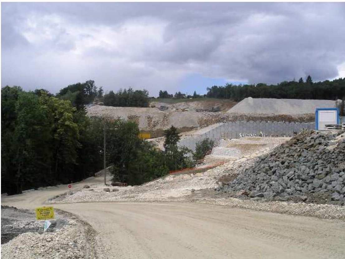
Photo 2 : Vue générale du chantier après mise en place du remblais (Juillet 2007)
