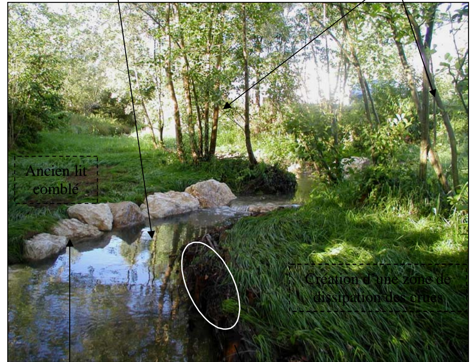
Un mois après travaux, août 2004
