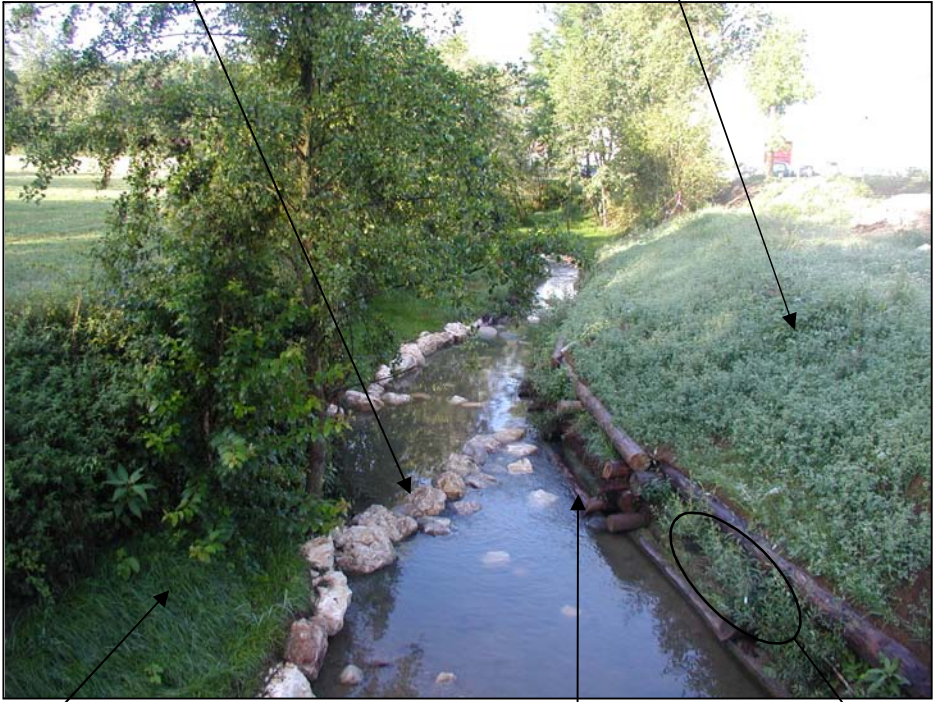
Un mois après travaux, août 2004
