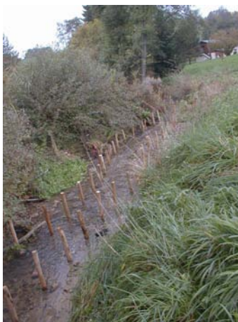
... pendant la réhabilitation...
