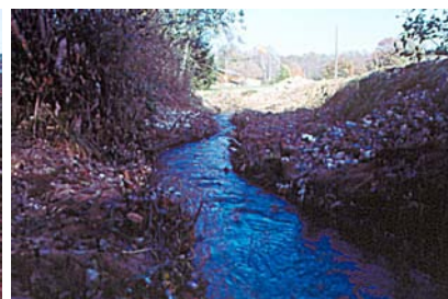
...juste après les travaux
