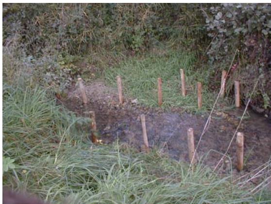
Enfoncement des pieux en châtaignier
