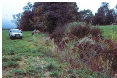
...avant travaux de réhabilitation...
