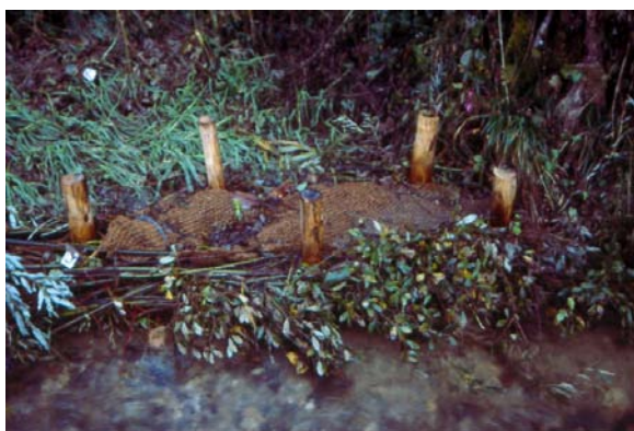
Sous-berge une fois le coco positionné
