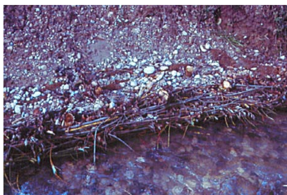
Sous-berge terminée, intégrée dans la berge
