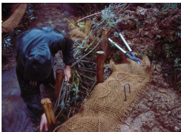
Branches de saules enfoncées à travers les tressages
