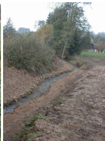
...juste après la réhabilitation
