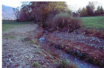
...juste après les travaux
