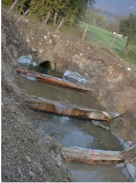
Vue de l'aval.
