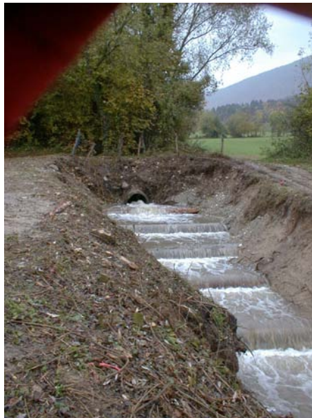
Vue de l'aval.
