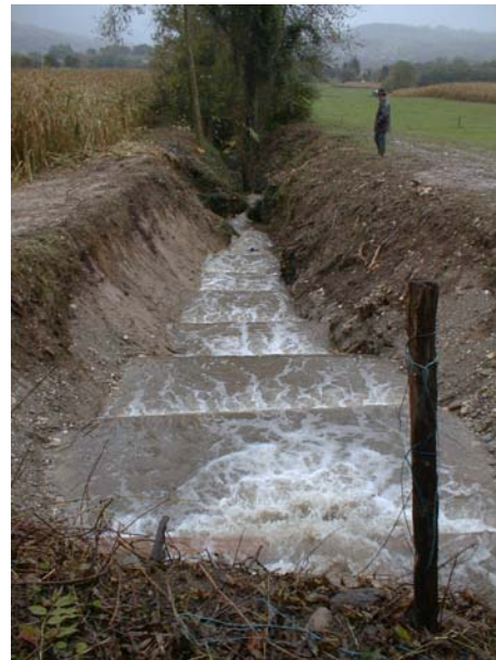
Vue de l'amont
