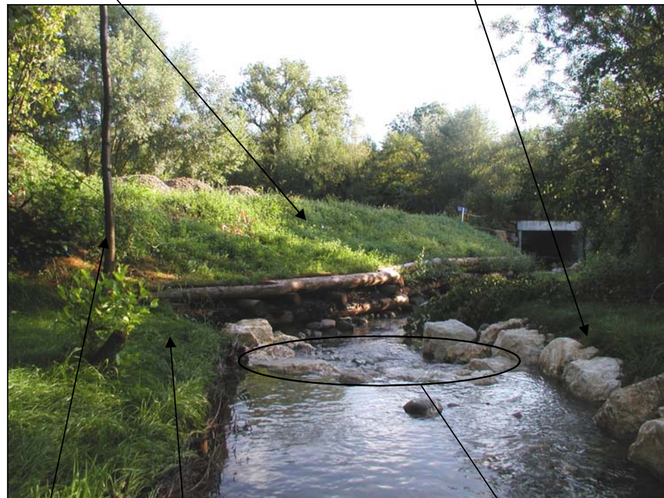
Un mois après travaux, août 2004
