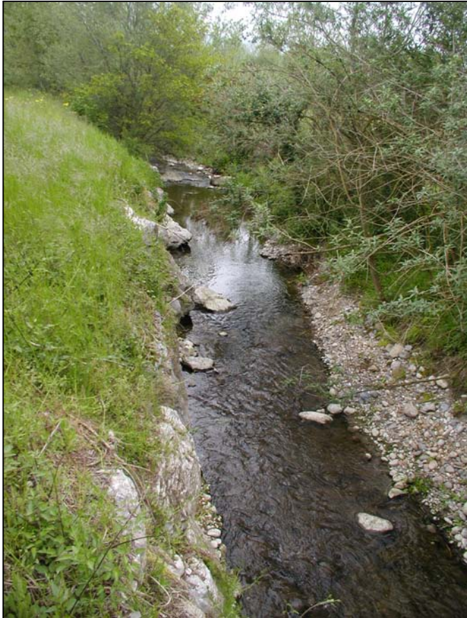
Avant travaux, avril 2004
