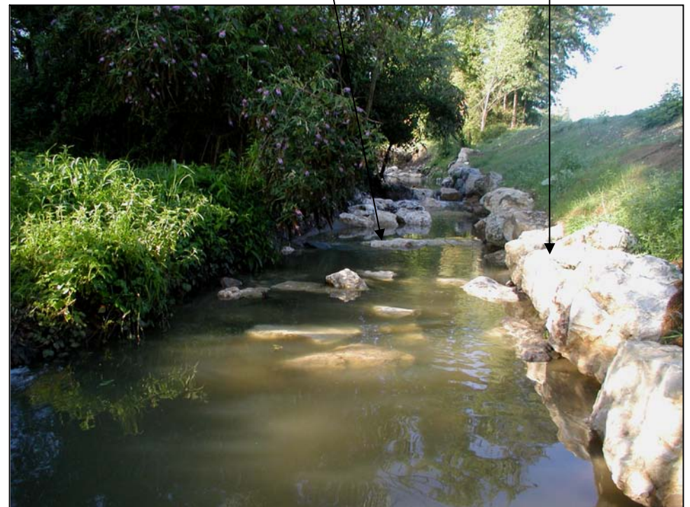
Un mois après travaux, août 2004
