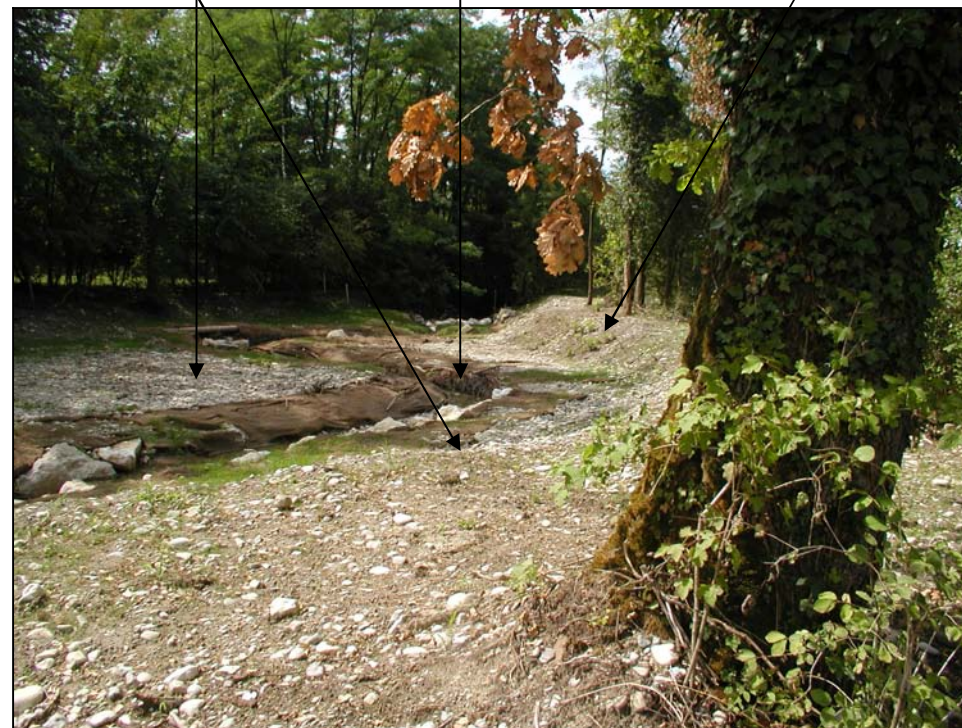
Un mois après travaux, août 2004
