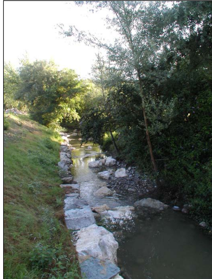
Un mois après travaux, août 2004
