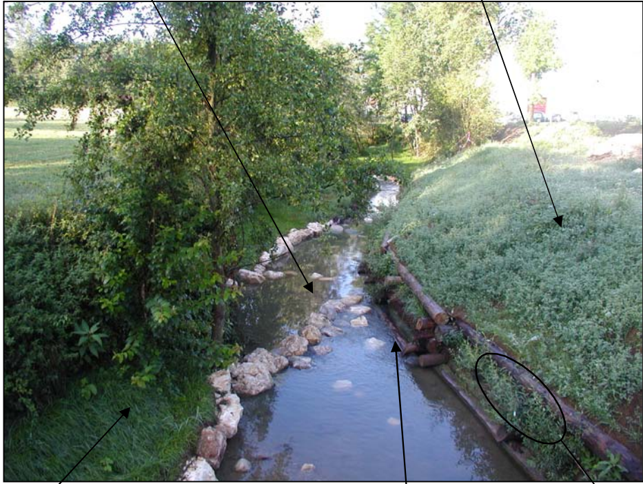
Un mois après travaux, août 2004
