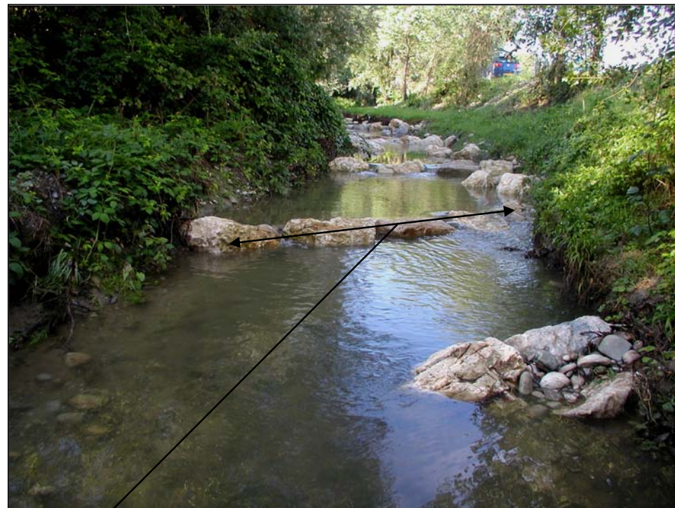
Un mois après travaux, août 2004, étiage sévère
