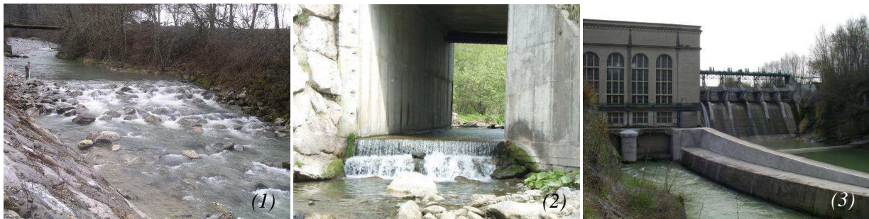
Figure 22 : Illustrations des types d'ouvrages rencontrés dans le département (1) seuil en enrochements libres pour la stabilité du profil en long, (2) ouvrage de franchissement routier ; (3) ouvrage de production hydroélectrique (Auteur : FDPPMA 74)
