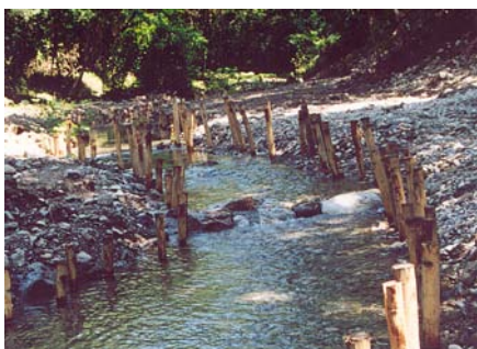
Petit seuil en pierres avec zone de frayère en amont
