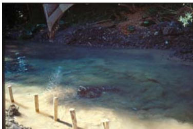
mise en place de blocs
