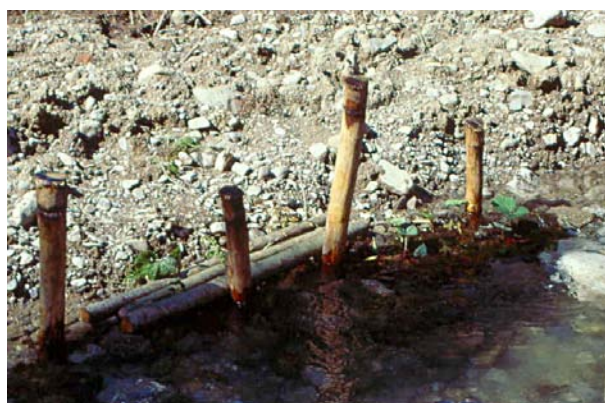
Construction d'une cache en sous-berge, vue pendant la construction et après reprise du tressage
