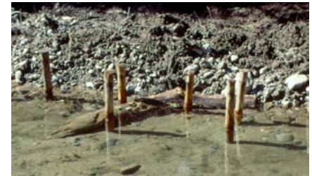
insertion de débris ligneux en berge
