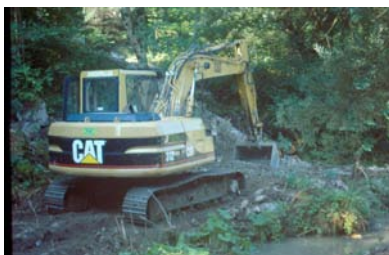
prise du graviers stockés
