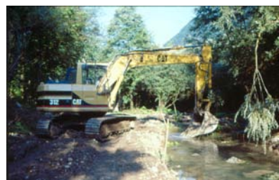
mise en place du graviers sur les zones de frayères potentielles
