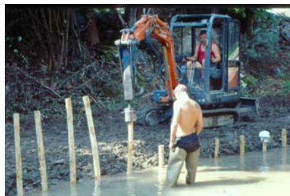
battage mécanique des pieux pour le tressage
