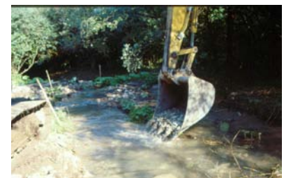
mise en place du graviers sur les zones de frayères potentielles
