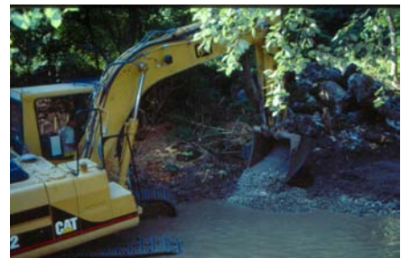
création de berge en matériaux graveleux et terreux
