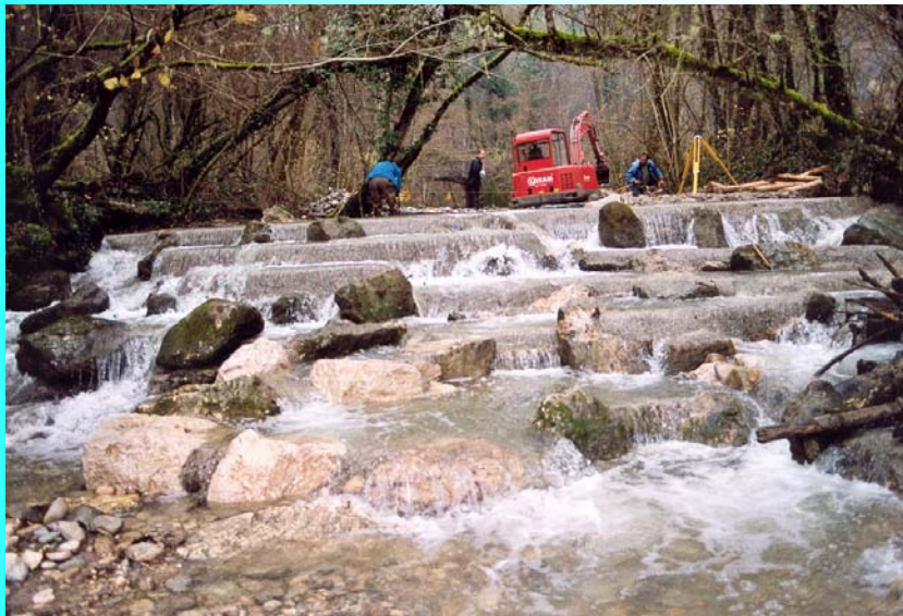
Aménagement du seuil infranchissable
