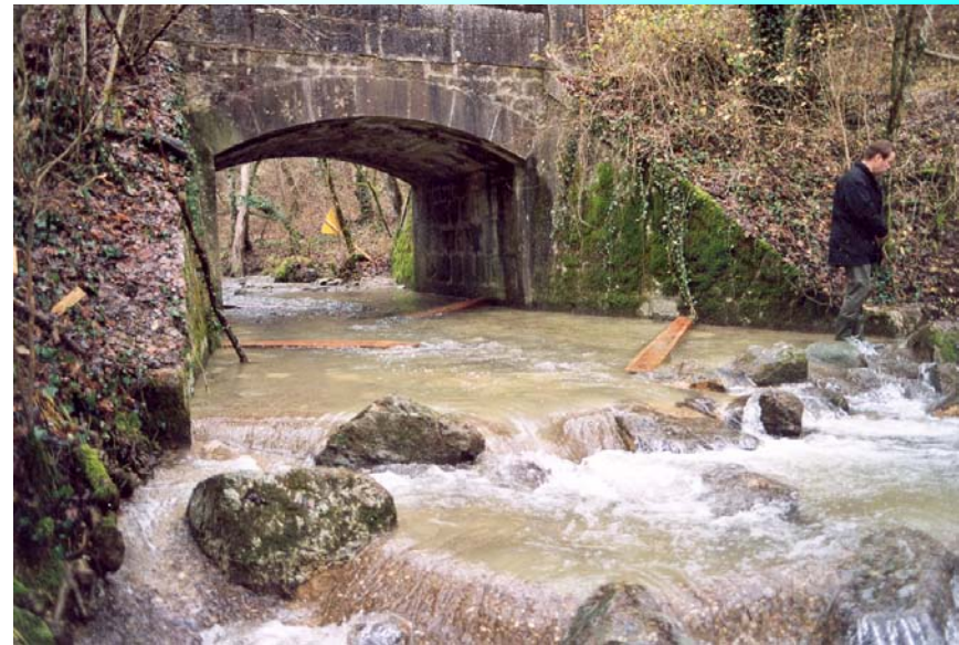
Pose de déflecteurs
