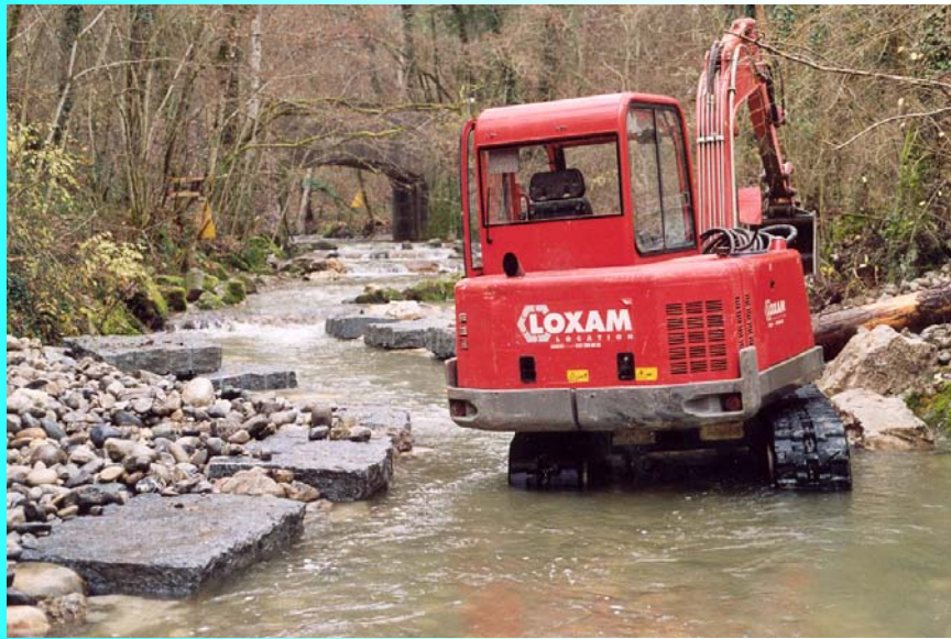
Pose de sous-berges en granit
