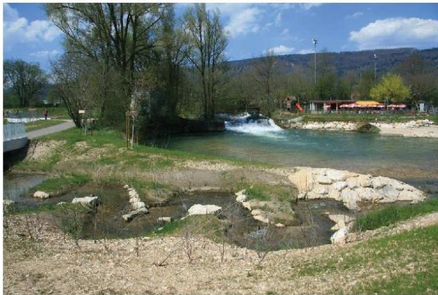
Exemple d'un ouvrage de contournement. La chute contournée est visible à droite au fond.
