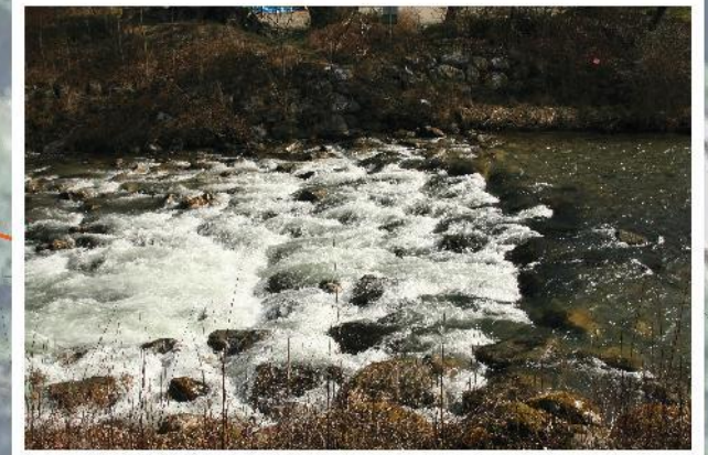
Seuil-rampe proche de l'embouchure
