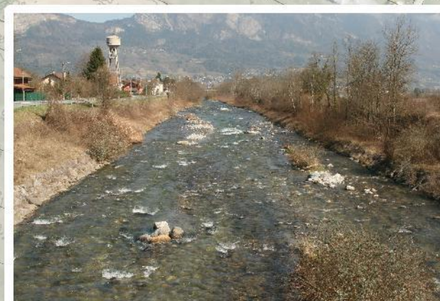
Ce tronçon possède une morphologie diversifiée de son lit. Des végétaux croissent dans le lit mineur, et au second plan un banc de galets est visible. L'écoulement est plus varié que sur les tronçons en aval.
