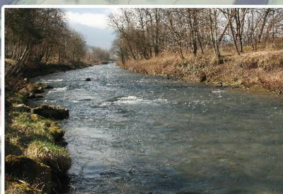
Le pied de berge est renforcé avec un enrochement partiellement végétalisé (végétation spontanée).
