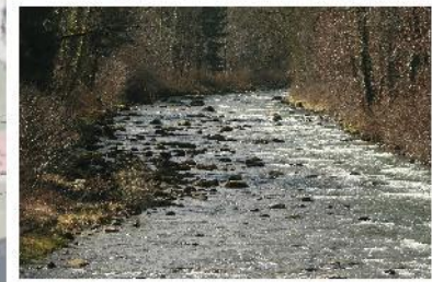
Lit structuré en amont du pont de la D27
