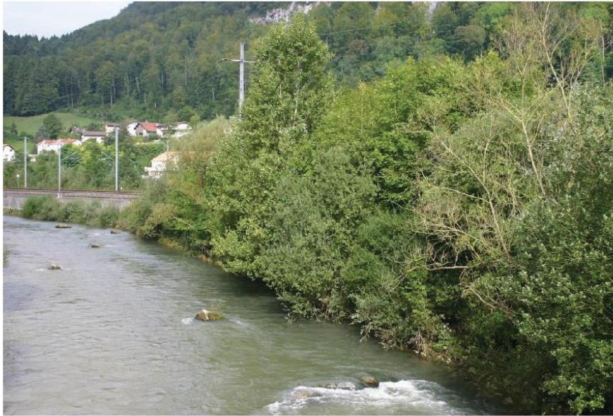
Blocs posés en marge du centre du cours d'eau .
