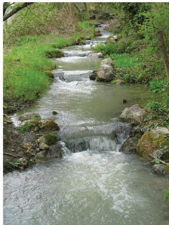
Rivière de contournement constituée d'une succession de seuils et de fosses de dissipation. Le caractère «naturel» est ici plus affirmé que sur le cliché du haut.
