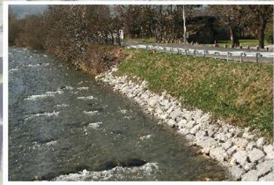
Pied de berge en enrochements libres et récents.
