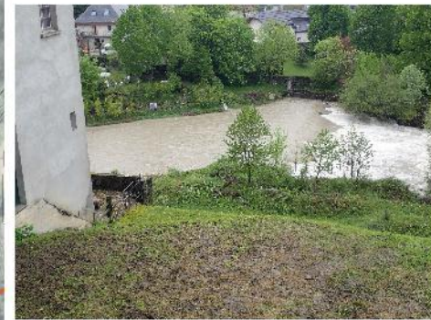
Seuil METRAL vu de la RD en temps de crue.
