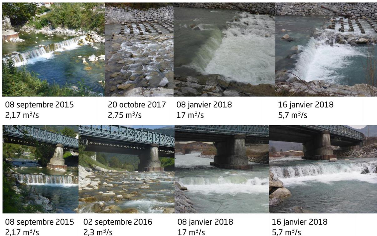
Figure 44 : Chronologie de l'état du seuil du pont SNCF de Marignier avant les travaux d'aménagement en 2015, une fois les travaux d'aménagement réalisés (2016–2017) et après les crues de fin décembre 2017 – début janvier 2018.
