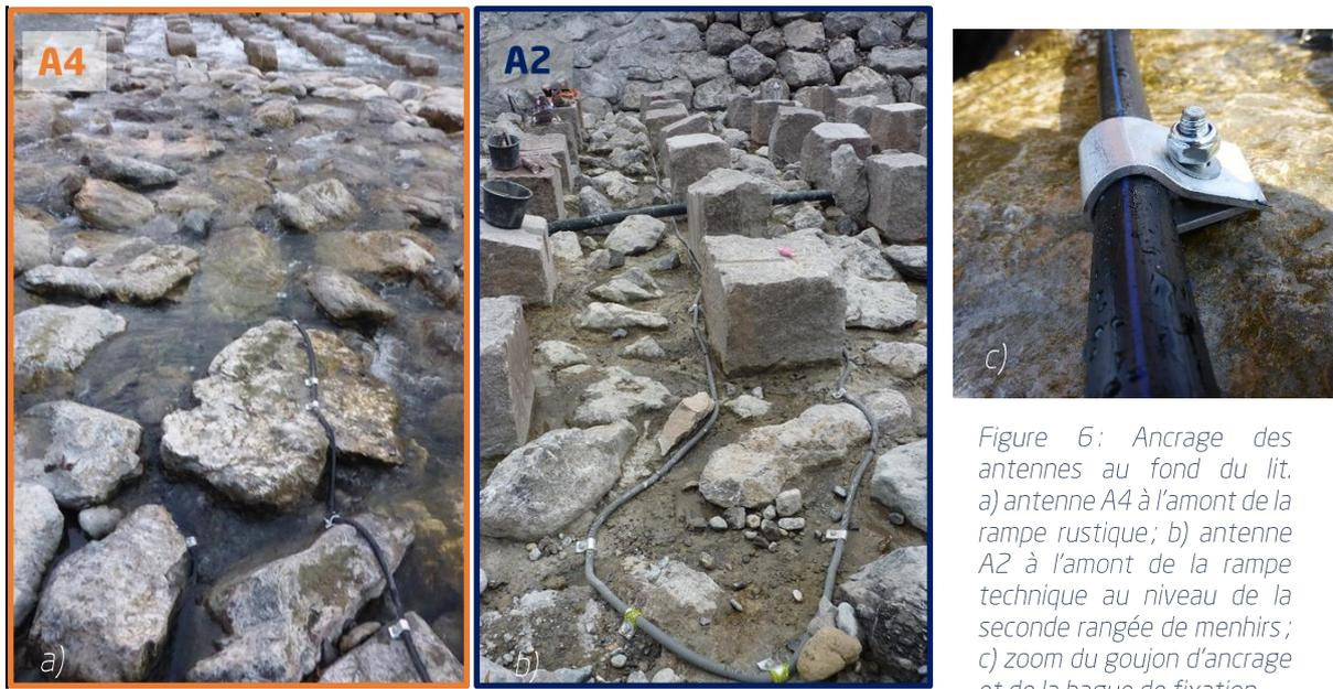
Figure 6: Ancre des antennes au fond du lit. a) antenne A4 à l'amont de la rampe rustique; b) antenne A2 à l'amont de la rampe technique au niveau de la seconde rangée de menhirs; c) zoom du goujon d'ancre et de la bague de fixation.
