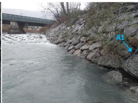
Engrèvement de l'aval de la passe suite à la crue du 6 novembre et recouvrement de l'antenne A1 par une couche épaisse de galets (env. 90 cm)
