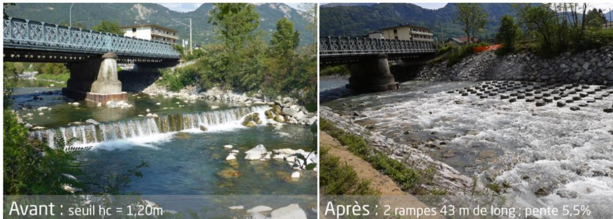
Figure 2 : Ouvrage du pont SNCF de Marignier sur le Giffre aval, avant et après aménagement.
