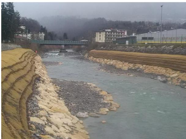
Figure 46 : Situation du tronçon canalisé du Giffre à l'aval de l'ouvrage du pont SNCF de Marignier à l'issue des travaux de restauration des digues. Source : SM3A
