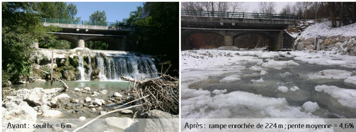
Figure 2 : Ouvrage du pont de Fillinges sur la Menoge avant et après aménagement.
