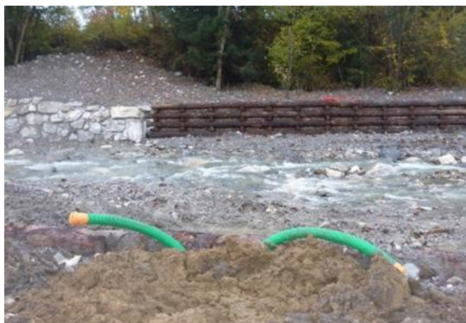
Fourreaux verts pour une rive et rouges pour la seconde
