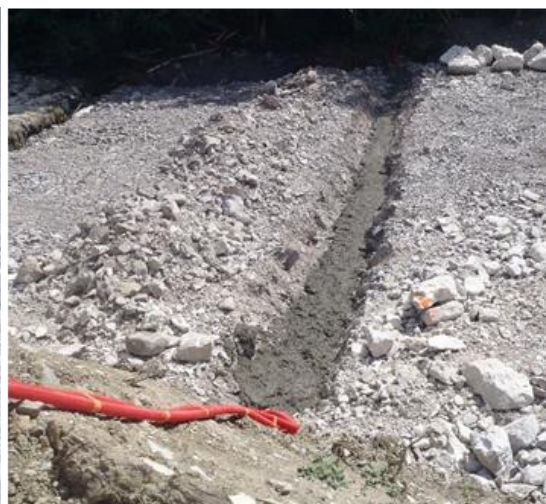
Pour stabiliser et protéger les fourreaux, la tranchée a été bétonnée
