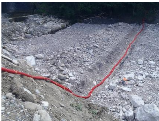
Pose des fourreaux dans la couche de fond de l'enrochement libre bicouche ; 1 seul fourreau suffit s'il est câblé au préalable
