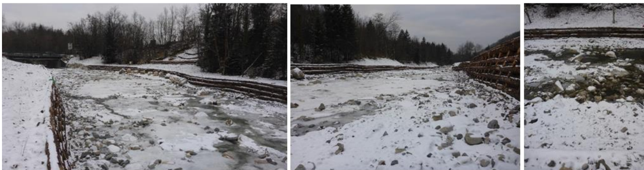
Figure 44 : Chronologie en images de l'évolution de la hydromorphologie de l'ouvrage depuis la réception des travaux en octobre 2016 jusqu'au mois de janvier 2017 au retour de la période de basses eaux.
