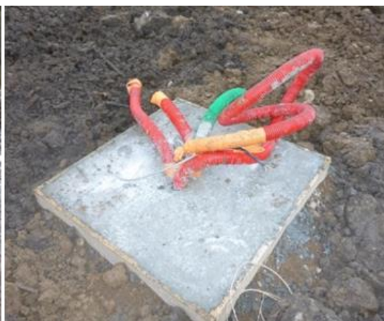
Différenciation aisée des fourreaux en fonction des rives au niveau de la plateforme béton
