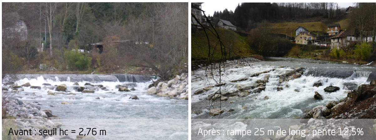
Figure 2 : Ouvrage du Seuil Métral avant et après aménagement
