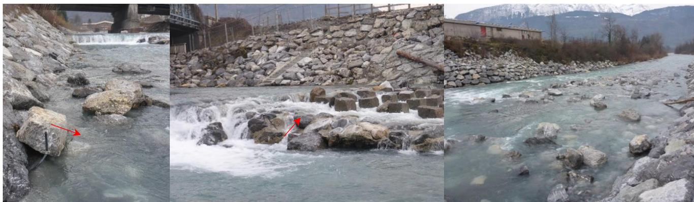
Figure 10 : Etat de la rampe enrochée rive droite et des antennes A3 et A4 après les crues de de fin décembre 2017 – début janvier 2018. Les flèches rouges indiquent les fragments d'antennes restants.
