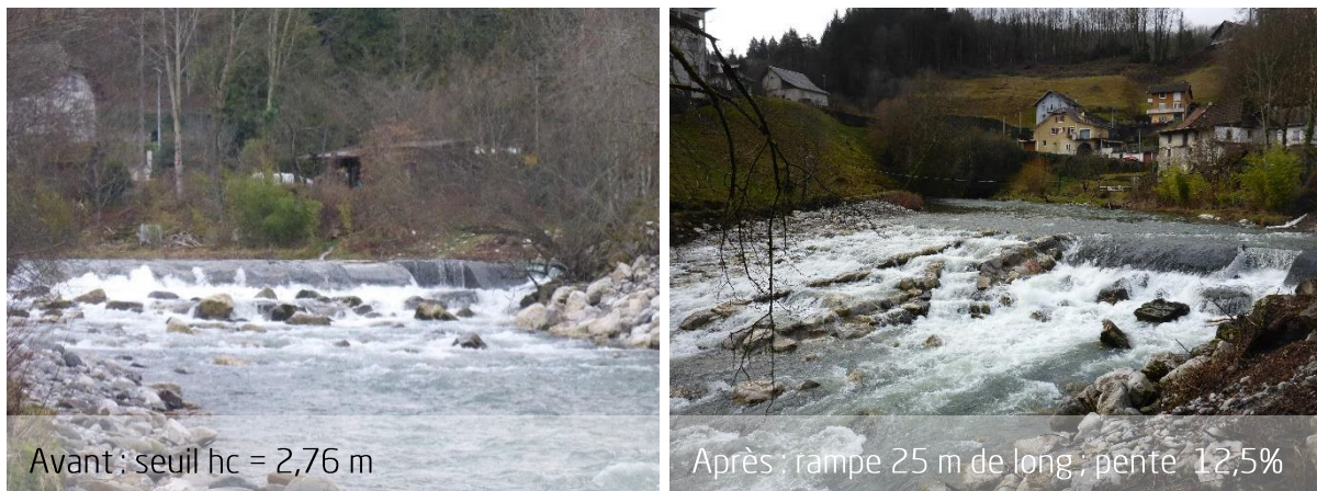
Figure 3 : Ouvrage du Pont du Diable (Seuil Métral) avant et après aménagement
