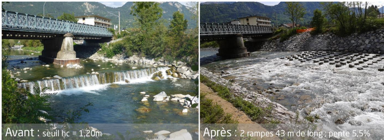
Figure 2 : Ouvrage du pont SNCF de Marignier avant et après aménagement
