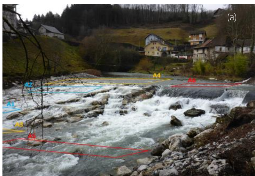
Figure 29: (a) Schéma de la disposition des antennes et leur dénomination, (b) sens de franchissement des poissons, (c) disposition de l'antenne (A4) amont rampe, (d) disposition de l'antenne amont rive gauche A6 (en l'absence de gros blocs, l'antenne a été fixée sur des bordures bétons, elles-mêmes maintenues au fond du lit par des fers à béton)
