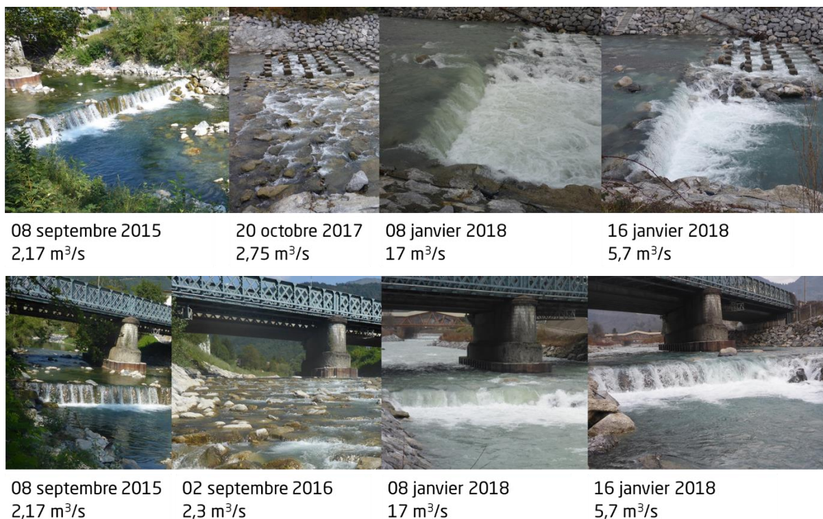
Figure 14 : Chronologie de l'état du seuil du pont SNCF de Marignier avant les travaux d'aménagement en 2015, une fois les travaux d'aménagement réalisés (2016–2017) et après les crues de fin décembre 2017 – début janvier 2018.
