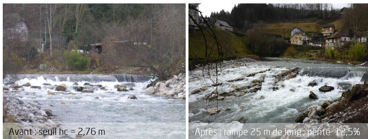
Figure 3 : Ouvrage du Pont du Diable avant et après aménagement
