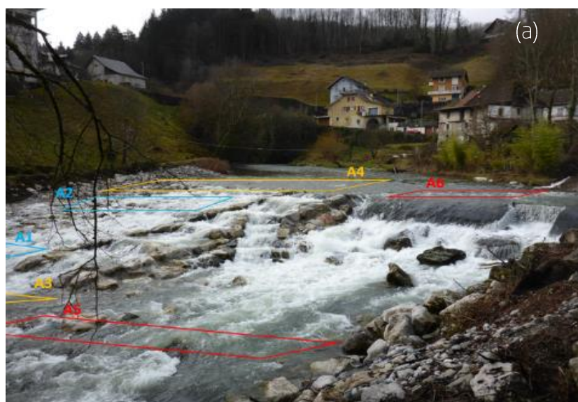
Figure 13: (a) Schéma de la disposition des antennes et leur dénomination, (b) sens de franchissement des poissons, (c) disposition de l'antenne (A4) amont rampe, (d) disposition de l'antenne amont rive gauche A6 (en l'absence de gros blocs, l'antenne a été fixée sur des bordures bétons, elles-mêmes maintenues au fond du lit par des fers à béton)
